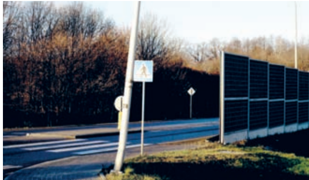
Na skrzyżowaniu ul. Wiejskiej z obwodnicą ekrany dźwiękochłonne oprócz emisji hałasu ograniczają także widoczność, a latarni przy przejściu dla pieszych nie pokrzywił wiatr...
