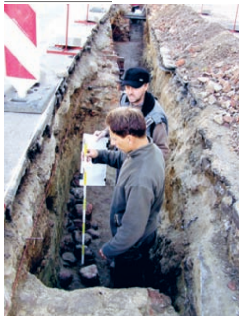
Remont sieci wodociągowej w mieście trwał już od dłuższego czasu. Podczas jego trwania archeolodzy ze średzkiego Muzeum Regionalnego prowadzili swój rutynowy nadzór.
