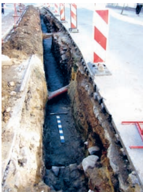
W bieżącym roku wspomniany wykop biegł w południowej części samej jezdni ul. Legnickiej i to dopiero w nim natrafiono na właściwą, południową partię przedbramia.
