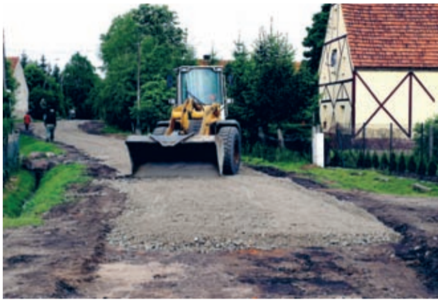
Prace w Proszkowie są bardzo zaawansowane a w wyniku realizacji projektu wszystkie gospodarstwa domowe otrzymają możliwość skorzystania z kanalizacji sanitarnej
