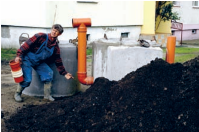
Prace związane z budową kanalizacji sanitarnej rozpoczęto również w Jastrzębcach
