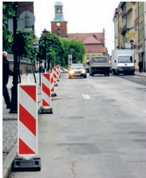
Trwa w najlepsze kanalizacja gminy. Sporo w tej kwestii dzieje się także w mieście.
