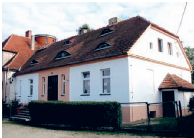
Zmodernizowaną i wyremontowaną świetlicą wiejską od niedawna mogą się cieszyć także mieszkańcy Słupa.
