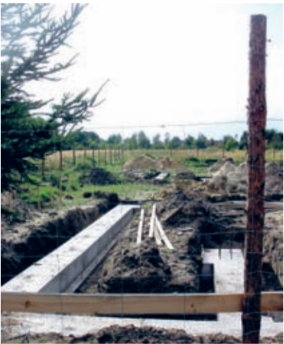
Budowa Lokalnego Centrum Aktywności Wiejskiej rozpoczęła się w Szczepanowie.
