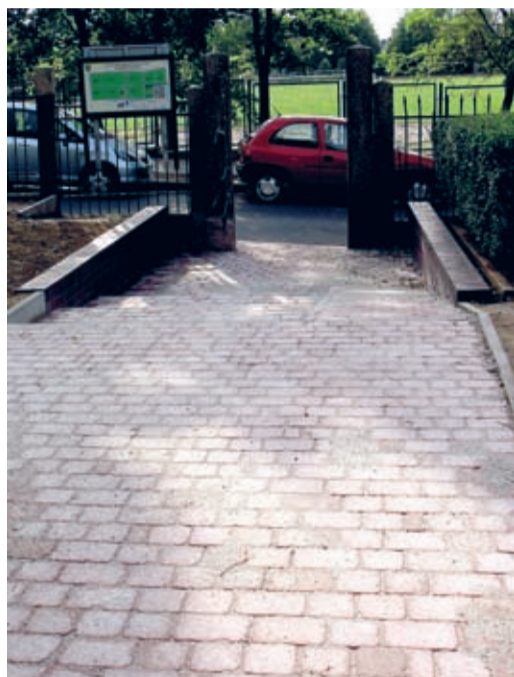
Przebudowane wejście na cmentarz od ul. Górnej.
