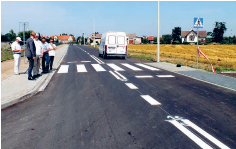
Inwestycje gminne - droga Krępice
