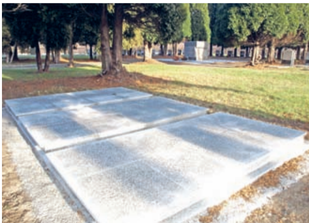
Zapadnięty grunt uzupełniono, wyrównano podłoże i ułożono nowe płyty z granitu.
