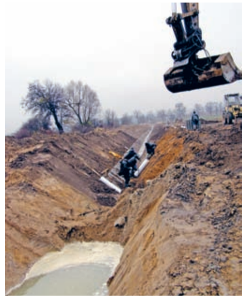
Końcowe prace przy rowie odwadniającym podstrefę.
