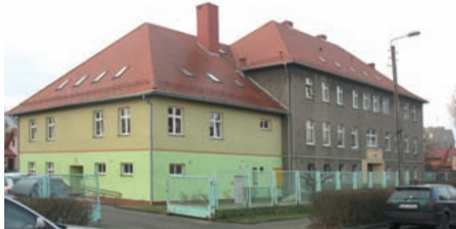
Nowy dach i nowe okna – Zespół Żłobkowo-Przedszkolny.
