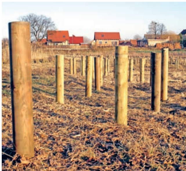
Brodno – pale pod pomosty spacerowe już są na swoich miejscach.
