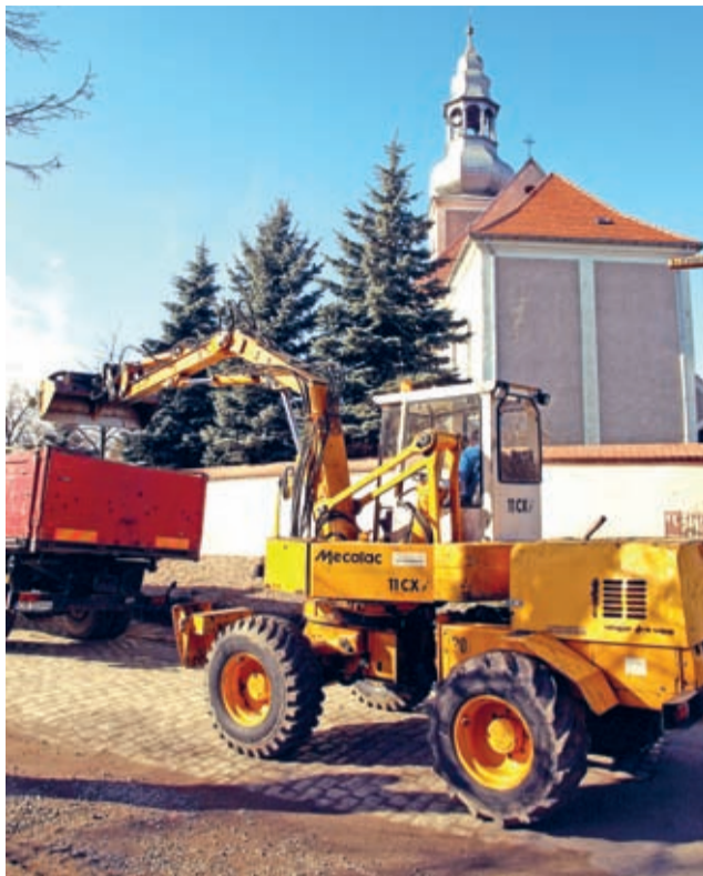
Święte – ruszyła budowa chodnika do Przedmościa
