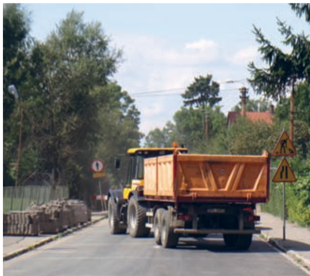
Prace na ul. Kolejowej trwają.
