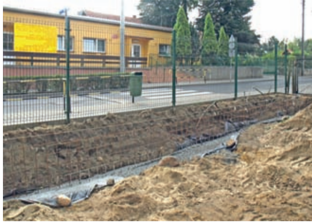
Prace przy SP3 w toku.
