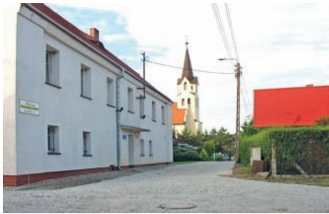
Tak wyglądał pierwszy etap prac (podbudowa pod nową nawierzchnię) – tu Bukówek.
