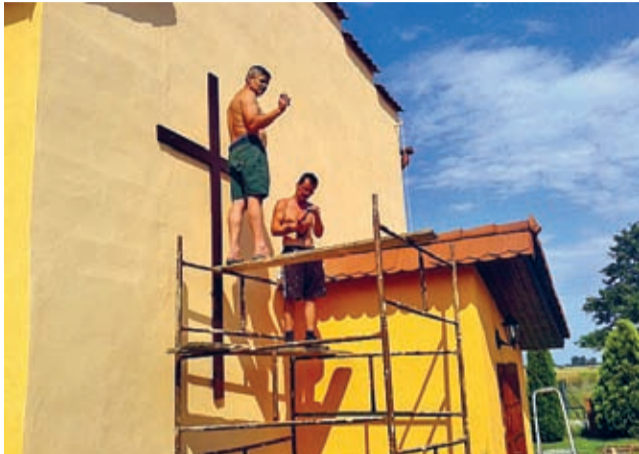
Jastrzębce – prace przy kaplicy.
