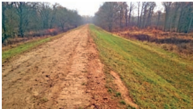
Zagęszczenie na wale Odry.
