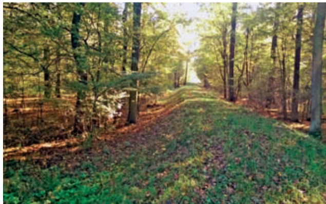
Wał przeciwpowodziowy Średzkiej Wody.
