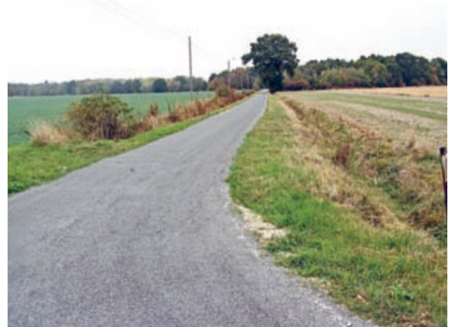
Nowa droga transportu rolnego w Szczepanowie
