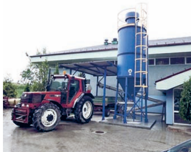
Przebudowa oczyszczalni ścieków w Piekarach
