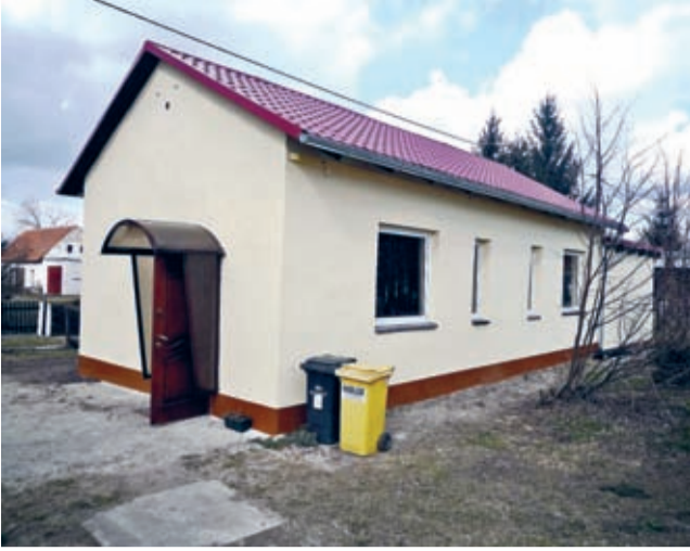
REMONT ŚWIETLICY JARZABKOWICE
