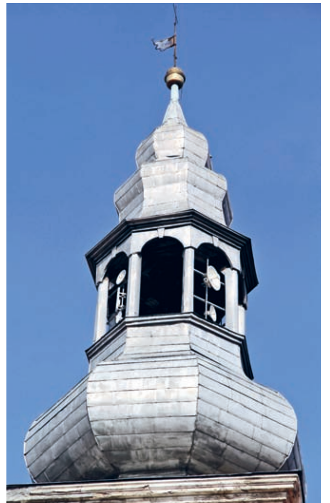
Wsparcie zostanie przeznaczone na remont hełmu wieży zabytkowego kościoła w Świętem.
