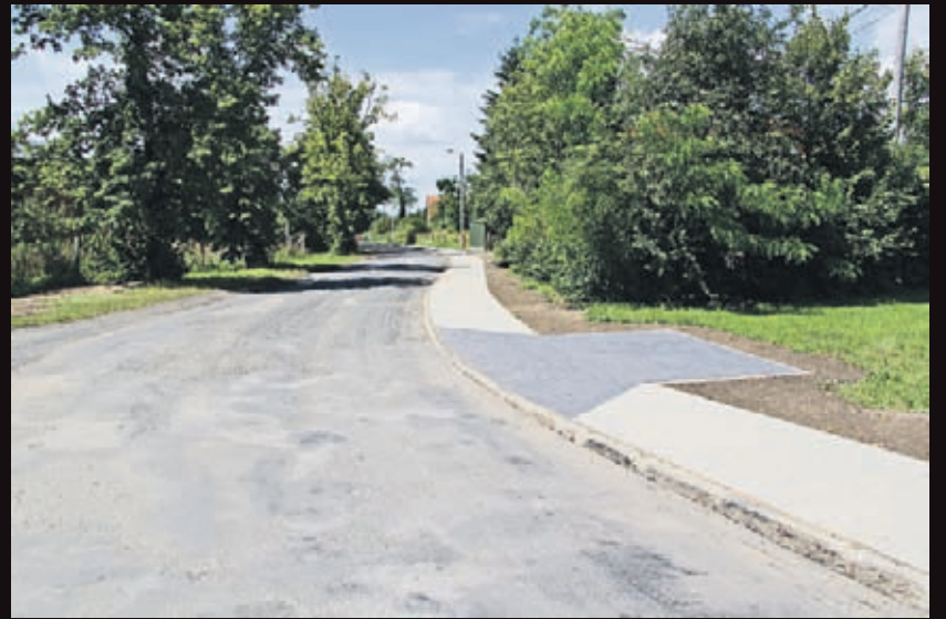
Dokończenie budowy chodnika w Komornikach, długość 135 m - wartość inwestycji 80 tys. złotych
