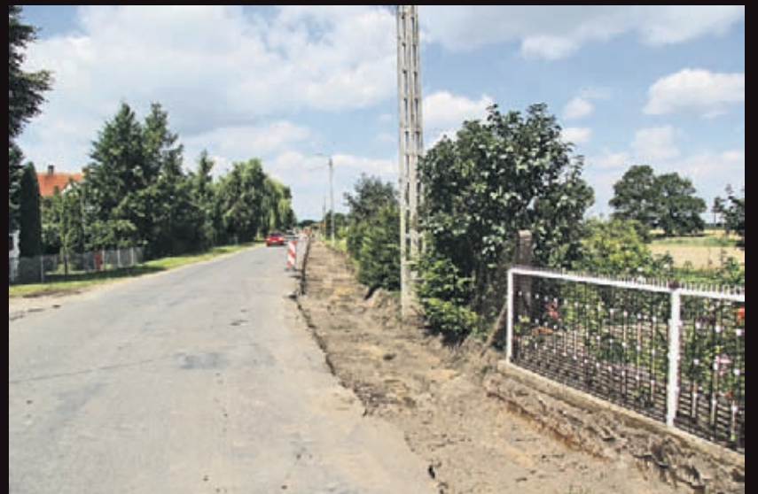
Budowa chodnika w Brodnie, długość 547 m - wartość 148 tys. złotych
