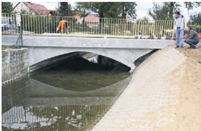
Przebudowa mostu w Ujeździe Górnym
