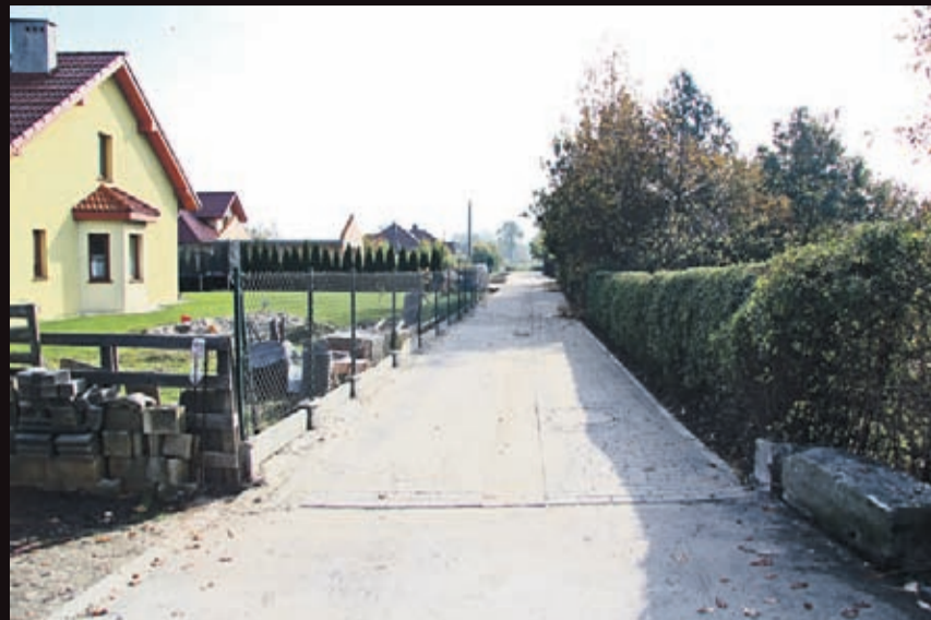
Przebudowa ul. Klonowej w Środzie Śląskiej.
