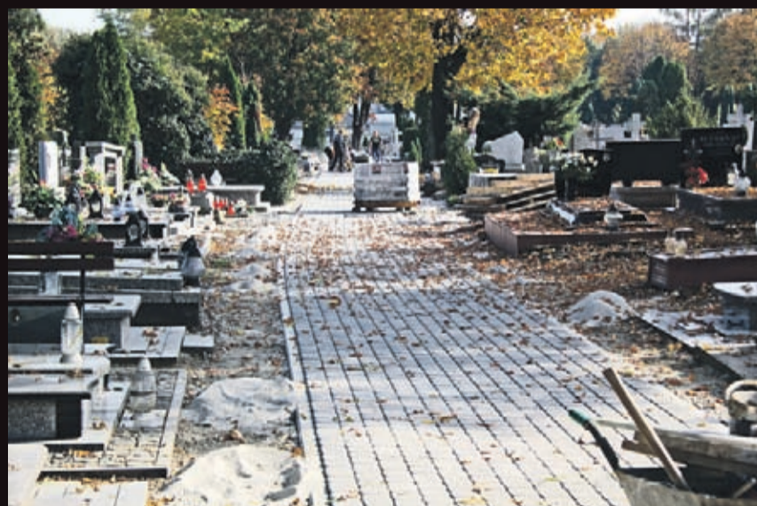
Budowa alejek na cmentarzu komunalnym w Środzie Śląskiej - etap III.
