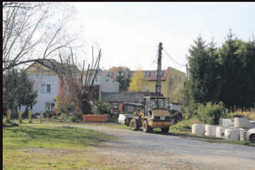
Budowa ciągów pieszo-jezdnych do targowiska miejskiego w Środzie Śląskiej.
