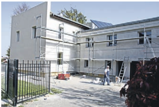
Termomodernizacja placówki opiekuńczo-wychowawczej dobiega końca
