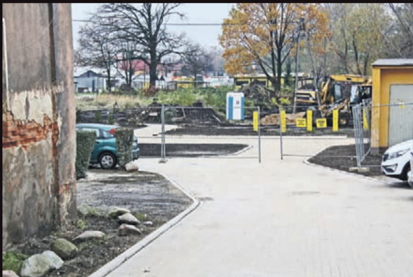
Budowa ciągów pieszo-jezdnych do targowiska miejskiego w Środzie Śląskiej. Wykonawca: firma Hemis – Bis z Prochowic.
