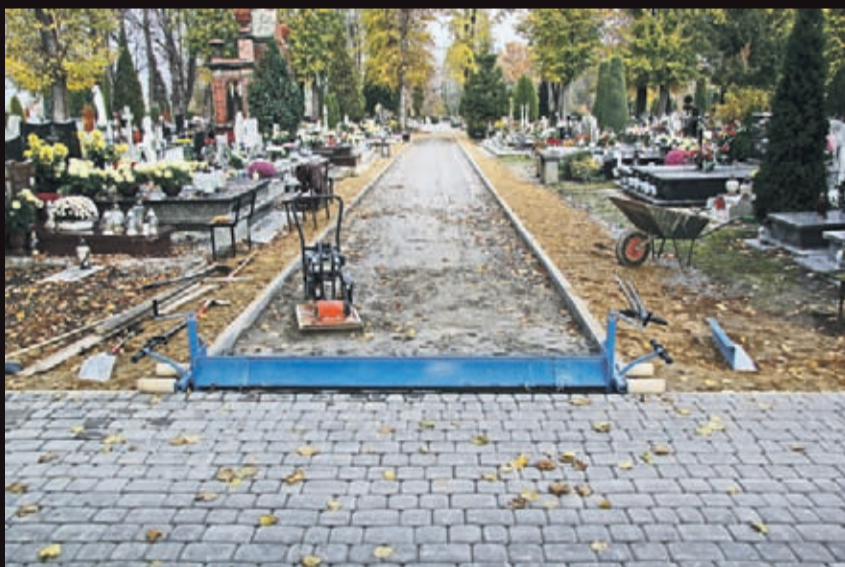
Budowa alejek na cmentarzu komunalnym w Środzie Śląskiej - etap III. Wykonawca: firma Instalator ze Środy Śląskiej.
