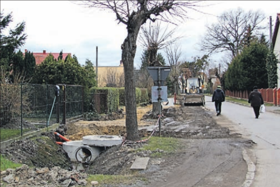
Budowa chodnika wraz z odwodnieniem w Świątym. Wykonawca: firma HEMIZ-BIS z Prochowic.
