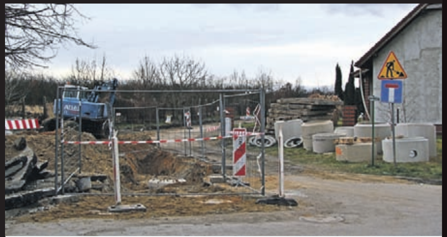
Budowa odcinka ul. Winogronowej w Środzie Śląskiej. Wykonawca: firma FOBIS z Lubina.
