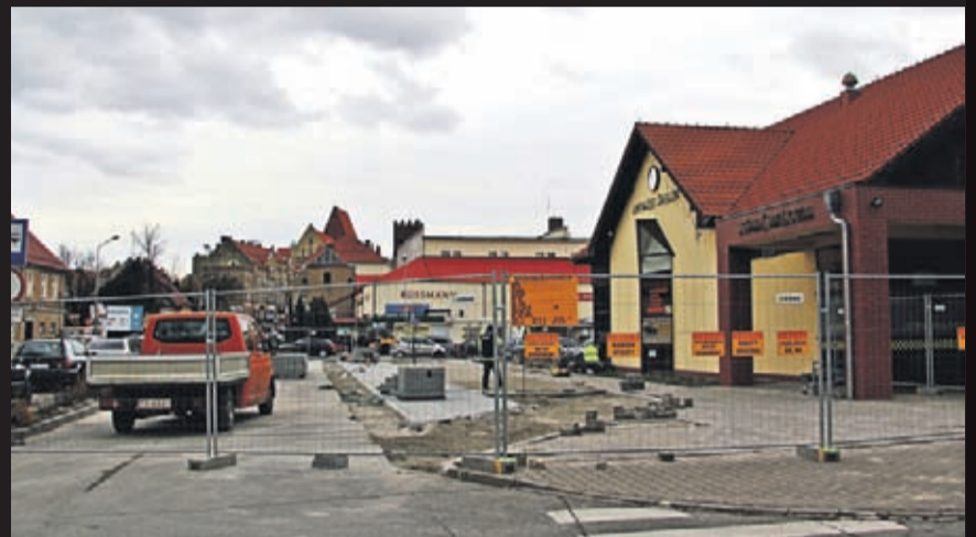
Budowa zintegrowanego peronu komunikacji miejskiej i taxi przy gminnym dworcu autobusowym w Środzie Śląskiej. Wykonawca: firma Instalator ze Środy Śląskiej.
