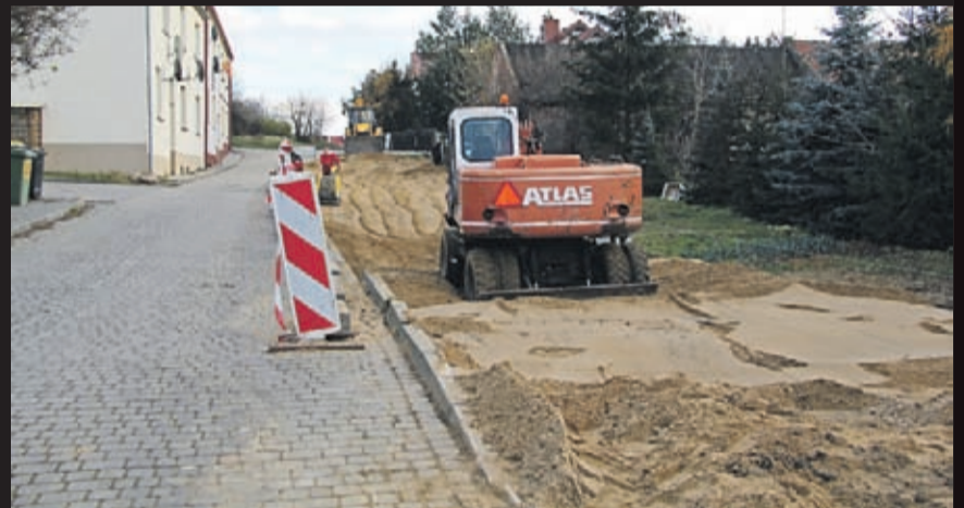
Przebudowa ul. Probusa w Środzie Śląskiej. Wykonawca: firma Instalator ze Środy Śląskiej.
