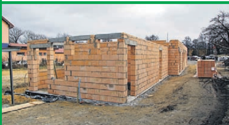
Przebudowa targowiska miejskiego w Środzie Śląskiej. Wykonawca: P&D Przemysław Drabik
