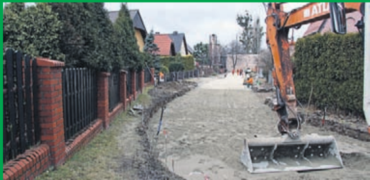
Przebudowa części ul. Rakoszyckiej w Środzie Śląskiej, tzw. sięgacza. Wykonawca: firma Instalator ze Środy Śląskiej.
