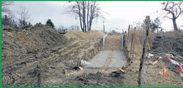
Budowa łącznika schodowego między ul. Kilińskiego a ul. Sikorskiego w Środzie Śląskiej. Wykonawca: firma Hemiz-Bis z Prochowic.
