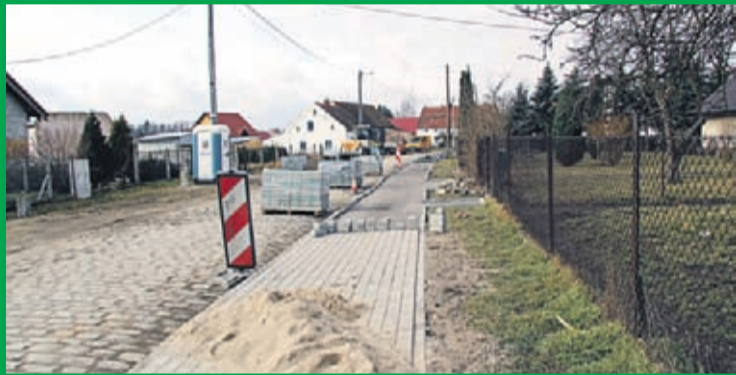
Budowa chodnika w miejscowości Jastrzębce. Wykonawca firma Hemiz-Bis z Prochowic.
