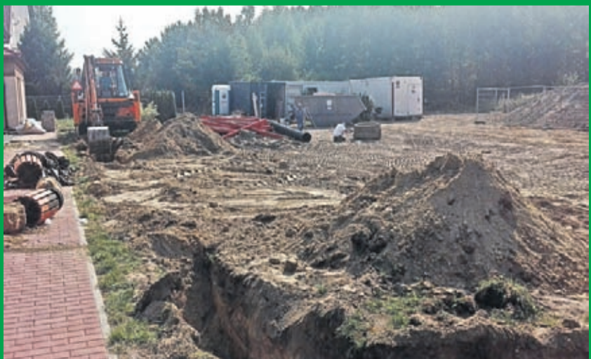
Rozbudowa Przedszkola w Szczepanowie. Wykonawca: Firma El-Sol z Lubczy.
