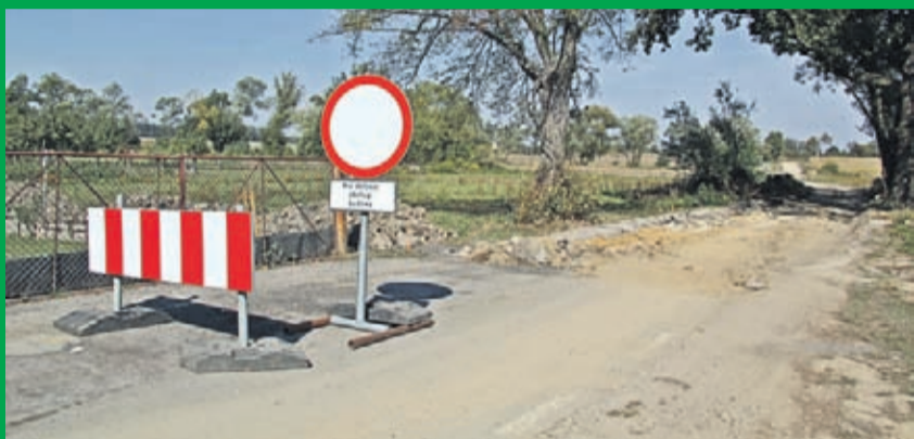
Przebudowa drogi Juszczyń – Wojczyce. Wykonawca: BERGER BAU z Wrocławia.
