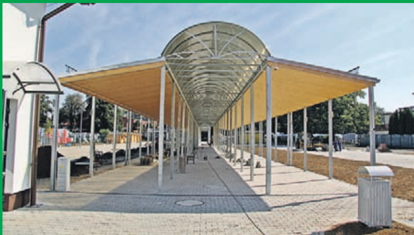
Przebudowa targowiska miejskiego w Środzie Śląskiej. Wykonawca: P&D Przemysław Drabik z Brzegu Dolnego.
