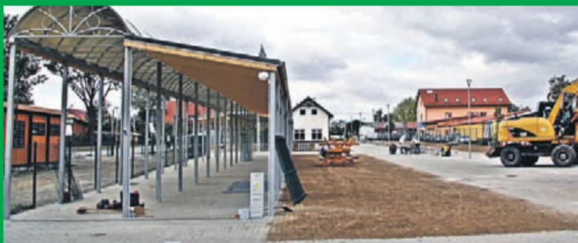
Przebudowa targowiska miejskiego w Środzie Śląskiej. Wykonawca: P&D Przemysław Drabik z Brzegu Dolnego.
