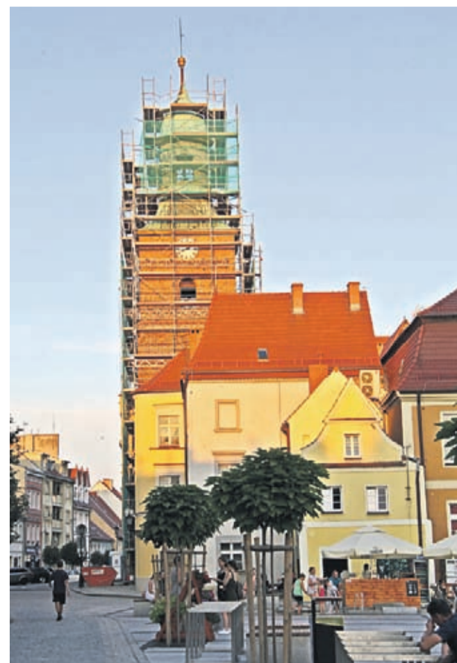
Wieża w trakcie remontu - sierpień 2018
