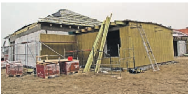
Budowa modułu przedszkola w toku - grudzień 2018
