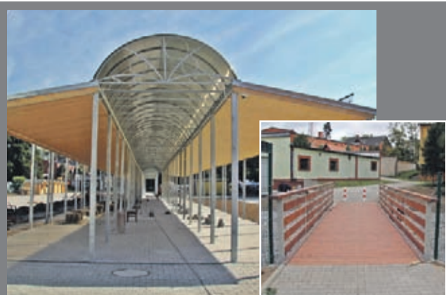
Przebudowa targowiska miejskiego w Środzie Śląskiej Wartość zadania – 3 442 328 zł
