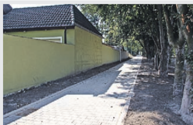
Przebudowa al. Janusza Korczaka w Środzie Śląskiej Wartość zadania – 282 232 zł
