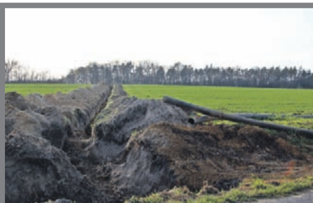
Budowa przesyłu kanalizacji do Lipnicy Wartość zadania – 690 159 zł
