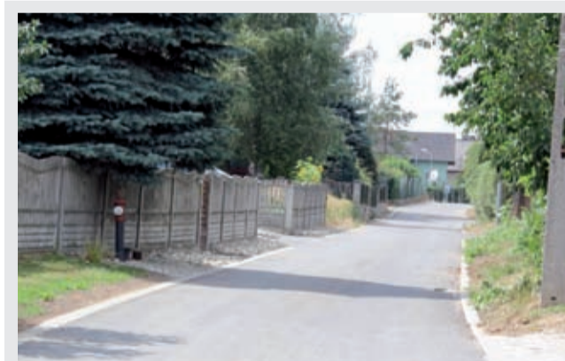
Nowa nawierzchnia ulicy Słonecznej w Ciechowie Wartość zadania – 258 500 zł
