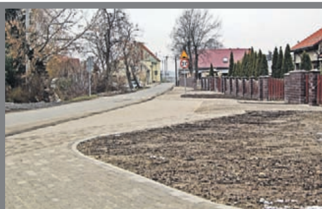
Budowa chodników i zatoki autobusowej w Juszczyń - etap I Wartość zadania – 267 915 zł
