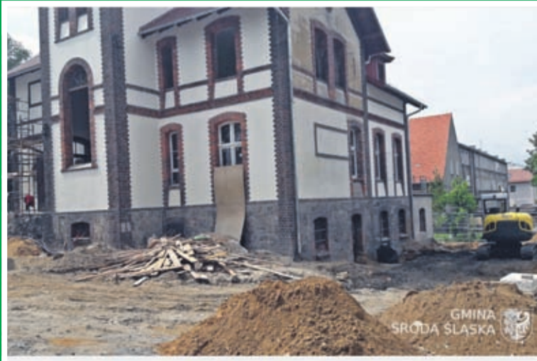
6. Budowa centrum NGO w Środzie Śląskiej Wartość inwestycji: 2.398.146 zł. Wykonawca: P&D w Brzegu Dolnym.
