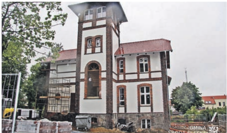
3. Budowa centrum NGO w Środzie Śląskiej Wartość inwestycji: 2.398.146 zł. Wykonawca: P&D
