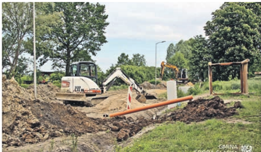
5. Budowa kanalizacji w Lipnicy Wartość inwestycji: 2 900 000 zł. Wykonawca: PIEC-BUD
