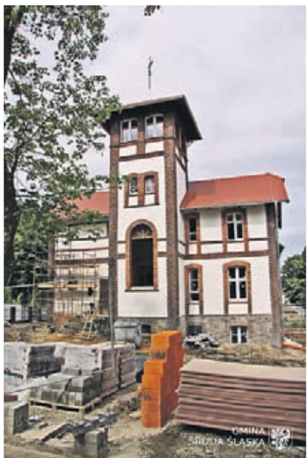
1. Budowa centrum NGO w Środzie Śląskiej Wartość inwestycji: 2.398.146 zł. Wykonawca: P&D
