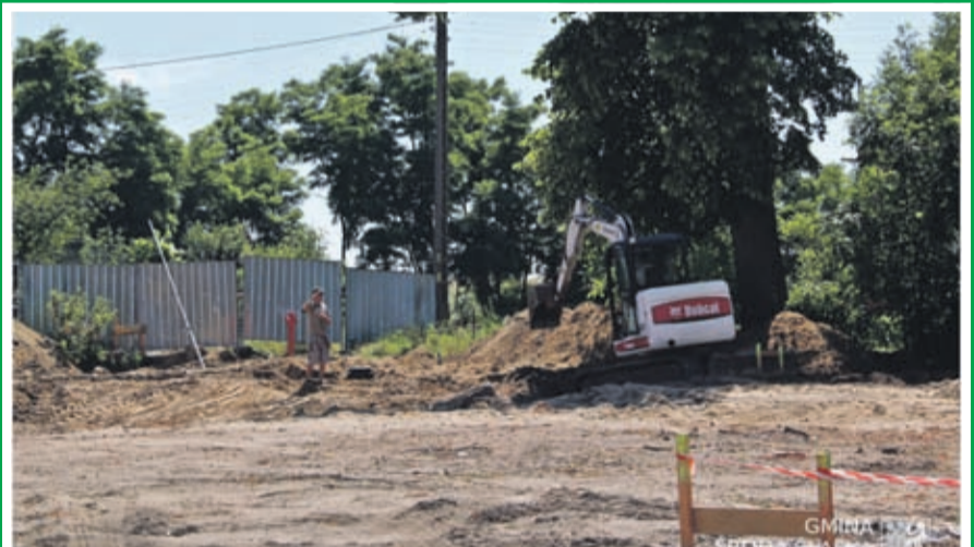
3. Budowa Rakoszyckiego Centrum Czytelnictwa i Kultury Lokalnej w Rakoszycach Wartość inwestycji: 1 490 000 zł. Wykonawca: EL-SOL INSTALACJE z Lubszy.
