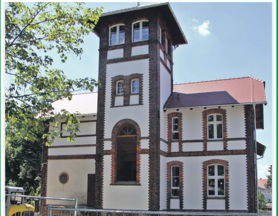
2. Budowa centrum NGO w Środzie Śląskiej Wartość inwestycji: 2.398.146 zł. Wykonawca: P&D
