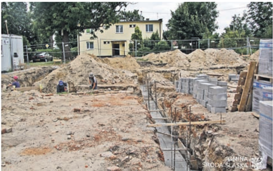
2. Budowa Rakoszyckiego Centrum Czytelnictwa i Kultury Lokalnej w Rakoszycach Wartość inwestycji: 1 490 000 zł. Wykonawca: EL-SOL INSTALACJE z Lubczy.
