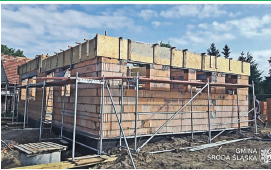
1. Budowa świetlicy wiejskiej w Kobylnikach Wartość inwestycji: 795.381 zł. Wykonawca: EL-SOL INSTALACJE z Lubczy.
