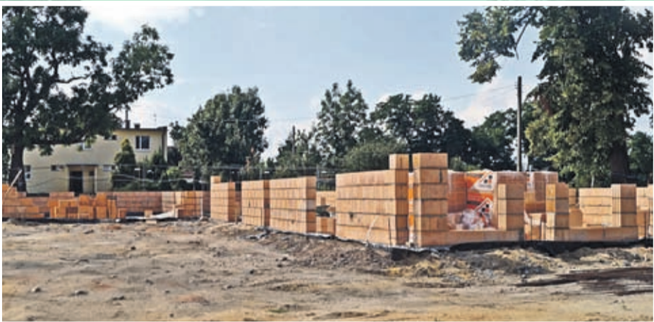
Budowa Rakoszyckiego Centrum Czytelnictwa i Kultury Lokalnej w Rakoszycach Wartość inwestycji: 1 490 000 zł. Wykonawca: EL-SOL INSTALACJE z Lubczy.
