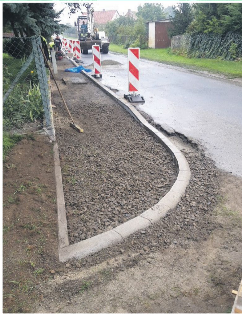
Budowa chodnika przy ul. Odrzańskiej w Rzęczy Wartość Inwestycji: 20 000zł. Wykonawca: Hemiz BIS z Prochowic
