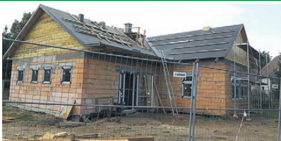
Budowa świetlicy wiejskiej w Kobylnikach Wartość inwestycji: 795 381zł. Wykonawca: EL-SOL INSTALACJE z Lubszy
