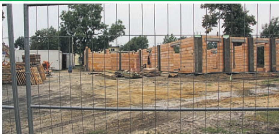
Budowa Rakoszyckiego Centrum Czytelnictwa i Kultury Lokalnej w Rakoszycach. Wartość Inwestycji: 1 490 000zł. Wykonawca: EL-SOL INSTALACJE z Lubszy
