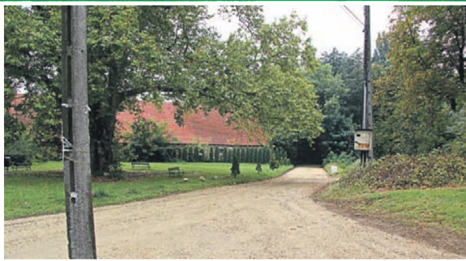
„Droga transportu rolnego Cesarzowice” Wartość inwestycji: 33.883,38 zł brutto. Wykonawca: BUDROMOS J.T. BIEŃKOWSCY SPÓŁKA JAWNA
