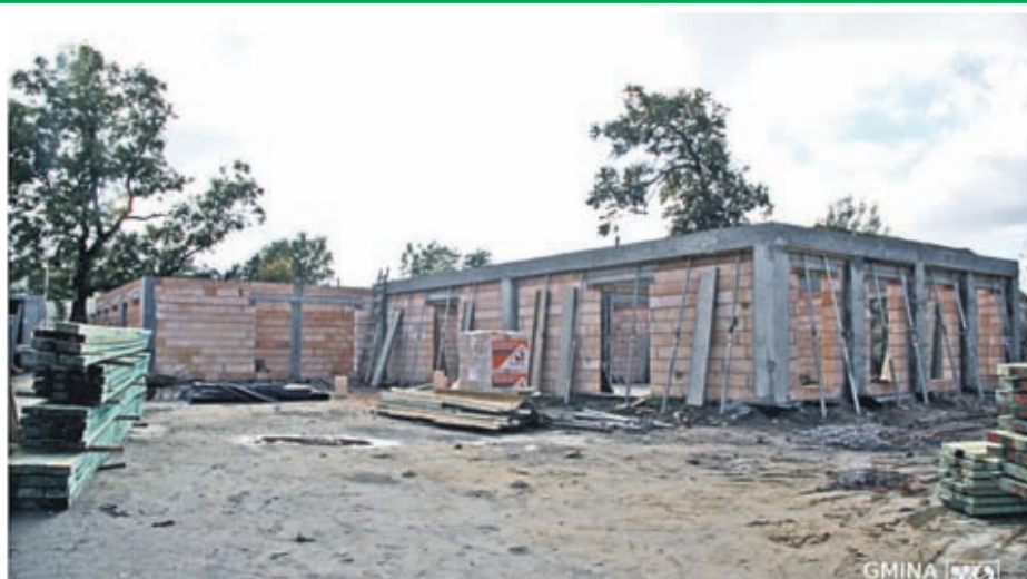
2. Budowa Rakoszyckiego Centrum Czytelnictwa i Kultury Lokalnej w Rakoszycach Wartość inwestycji: 1 490 000 zł. Wykonawca: EL-SOL INSTALACJE z Lubszy.
