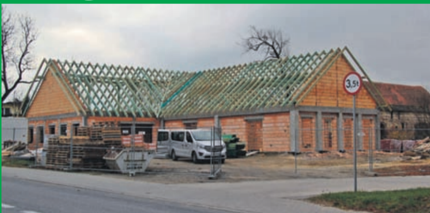
1. Budowa Rakoszyckiego Centrum Czytelniczo-Kulturalnego w Rakoszycach Wartość inwestycji: 1 490 000 zł. Wykonawca: EL-SOL INSTALACJE z Lubczy.
