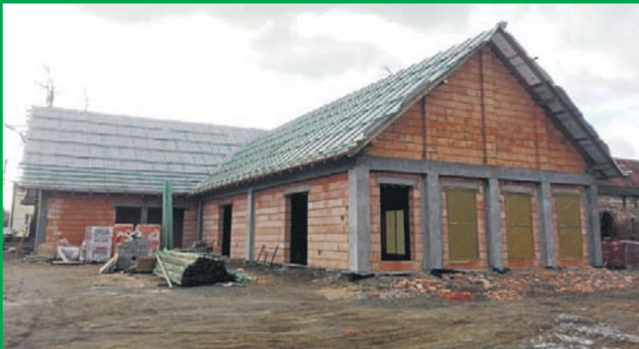
1. Budowa Rakoszyckiego Centrum Czytelnictwa i Kultury Lokalnej w Rakoszycach Wartość inwestycji: 1 490 000 zł. Wykonawca: EL-SOL INSTALACJE z Lubszy
