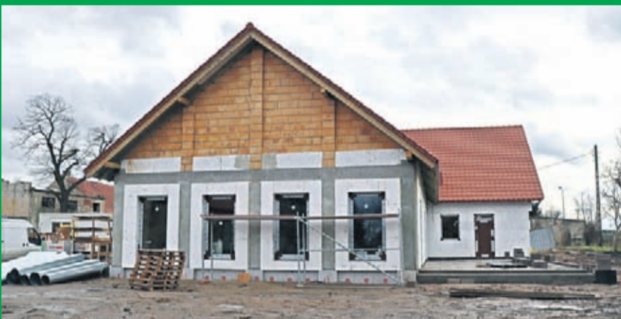
3. Budowa Rakoszyckiego Centrum Czytelnictwa i Kultury Lokalnej w Rakoszycach Wartość inwestycji: 1 490 000 zł. Wykonawca: EL-SOL INSTALACJE z Lubczy.
