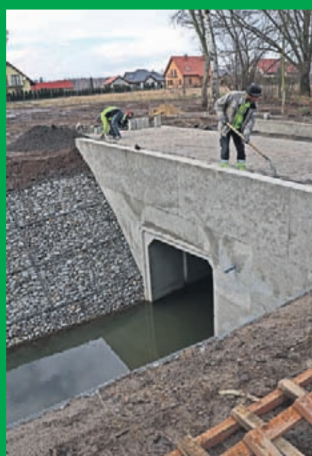
5. Budowa przepustu łączącego ul. Kopycyniecką z ul. Polną w Szczepanowie
