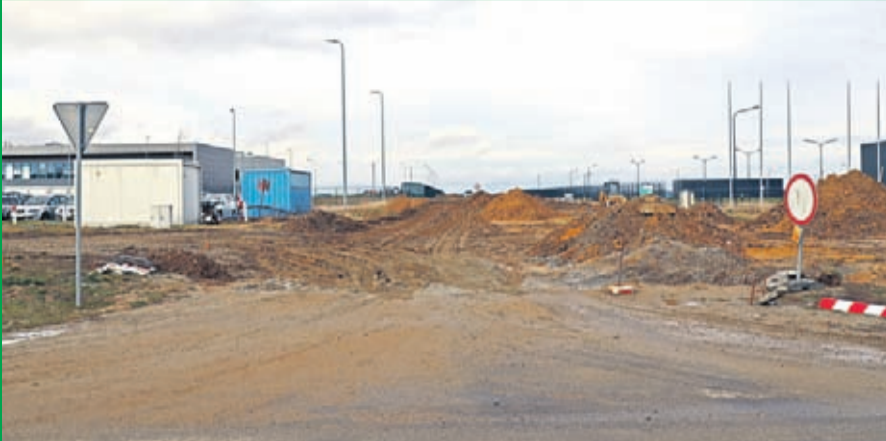
1. Budowa I Etapu drogi gminnej w podstrefie LSSE w Środzie Śląskiej Wartość inwestycji: 1.150.043 zł. Wykonawca: COLAS Polska Sp. z o.o. z Poznania.
