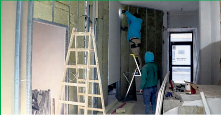
Adaptacja lokalu usługowego przy ul. Daszyńskiego 16C w Środzie Śl. na Dzienny Dom Seniora Wykonawca: TORUS z Brzegu Dolnego. Wartość inwestycji: 270 tys. zł.
