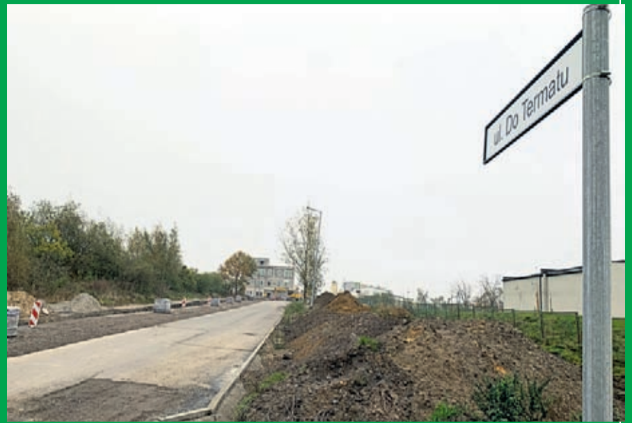
Przebudowa ul. Do Termatu w Środzie Śląskiej Wykonawca: Świdnickie Przedsiębiorstwo Budowy Dróg i Mostów. Koszt Inwestycji: 310 tys. zł
