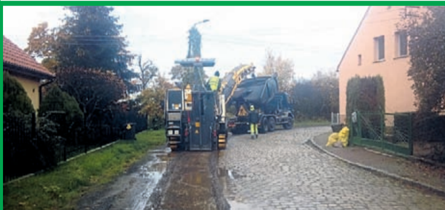
Modernizacja ścieżki rowerowej w ciągu ul. Lipnickiej w Szczepanowie Wykonawca: A.R.- BIT z Wrocławia. Koszt Inwestycji: 212 tys. zł
