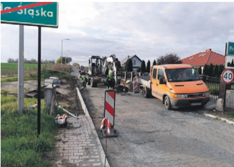
Roboty drogowe na ul. Reymonta w Proszkowie
