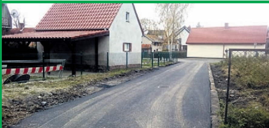
Rewitalizacja odcinków dróg dojazdowych między ul. Łąkową, Ogrodowa i Jaworową w Ciechowie. Wykonawca: EUROVIA z Jordanowa Śl. Koszt Inwestycji: 80 tys. zł
