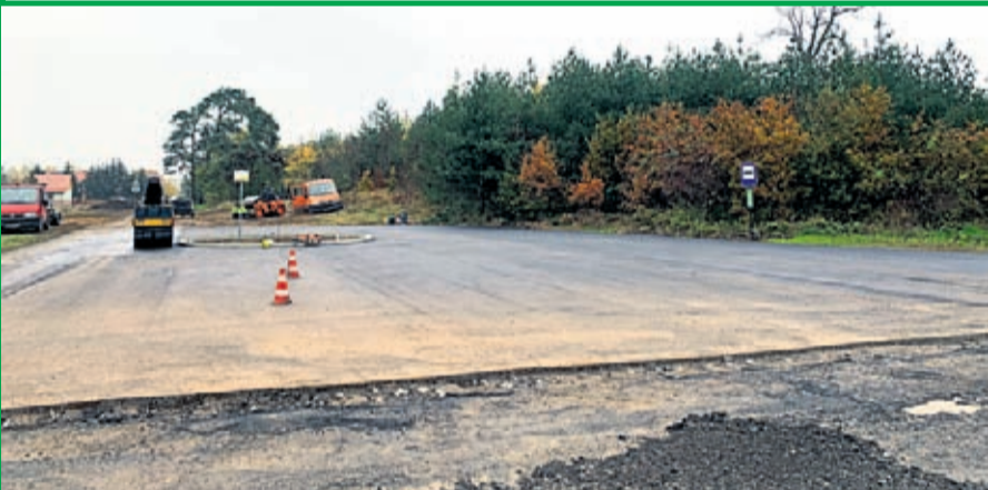
Wykonanie nawierzchni asfaltowej pętli autobusowej przy ul. Długiej w Szczepanowie Wykonawca: A.R.- BIT z Wrocławia. Koszt Inwestycji: 90 tys. zł
