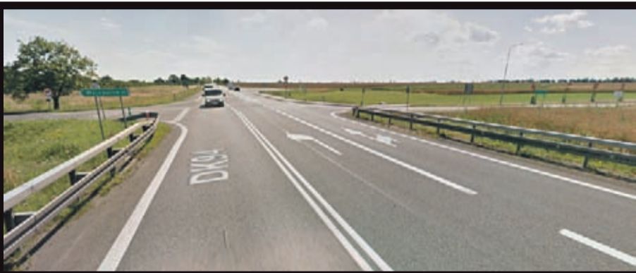
Skrzyżowanie DK94 z drogą gminną do Juszczyzna
