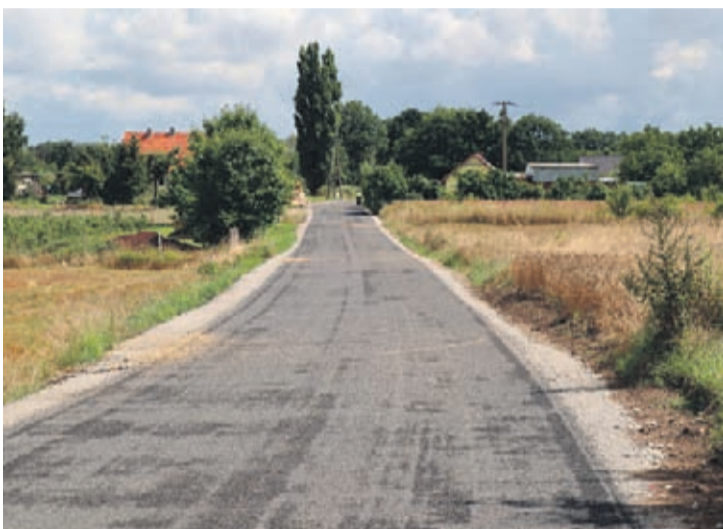
Ukończona droga transportu rolnego w Chwalimierzu
