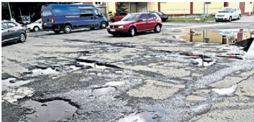
Droga wewnętrzna PKS-PULBUS – ul. Dworcowa
