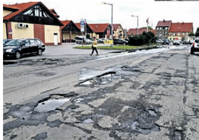
Droga wewnętrzna PKS-PULBUS – ul. Dworcowa
