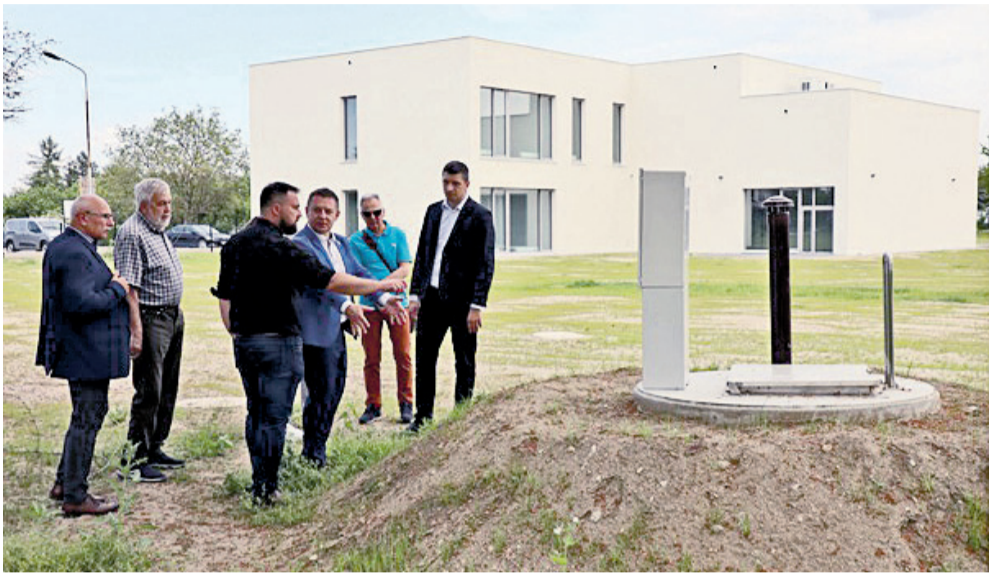
Przepompownia ścieków dedykowana dla obiektu ŚIP
